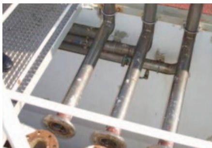
Ovan rör med dränering, nedan rör utan dränering.
